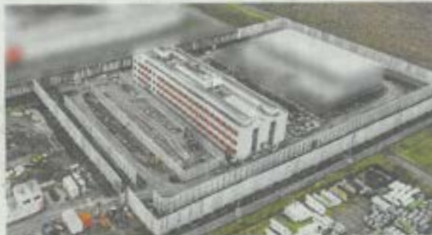
Luftaufnahme des neu gebauten Bereichs bei der Justizvollzugsanstalt Hall. Die bestehenden Gebäude wurden auf dem Bild per Grafikprogramm unkenntlich gemacht, um die Sicherheitsvorkehrungen nicht preiszugeben. Foto: Ufuk Arslan
