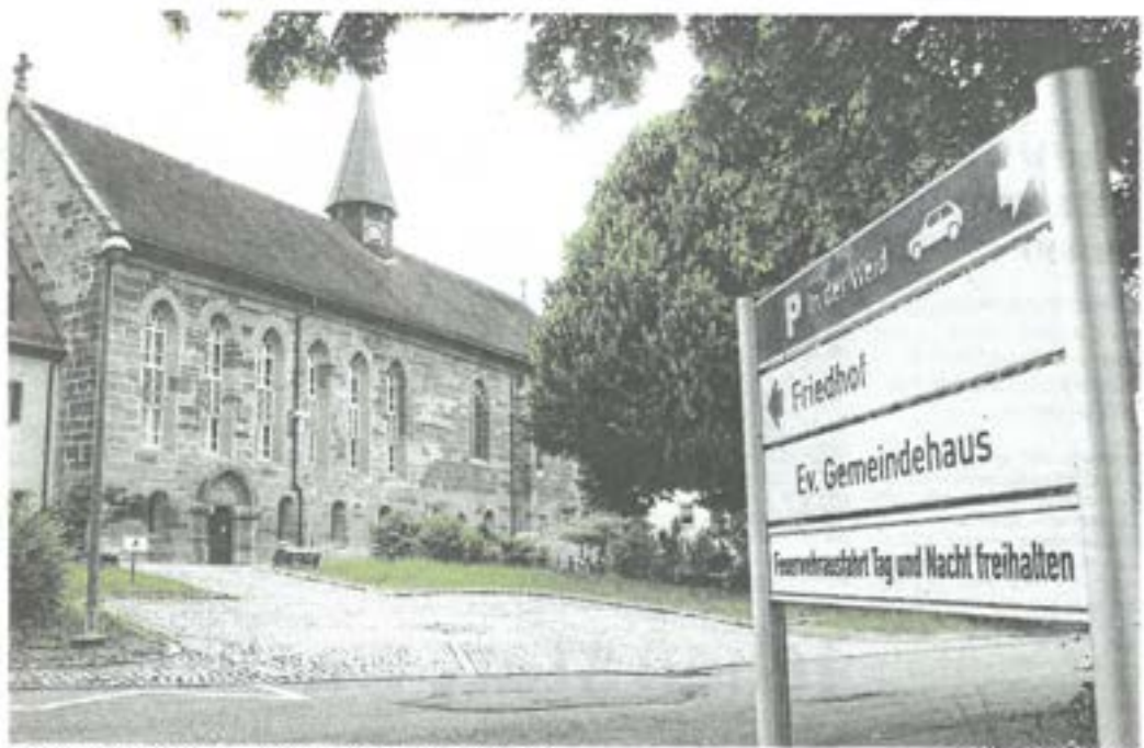
Der Vorplatz der Gnadentaler Klosterkirche soll umgestaltet werden.
