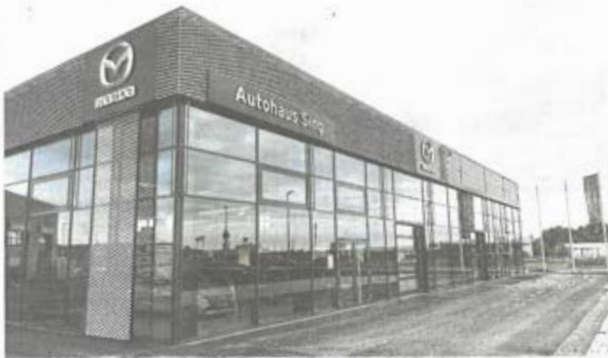
Das neue Gebäude, im Buchhorn 26, ist 1500 Quadratmeter groß. Eine große Ausstellingshalle, drei Werkstattplätze, die Bereiche Direktannahme, Aufbereitung, Fahrzeugwache, Technik, Lager sowie Büro sind hier untergebracht.
