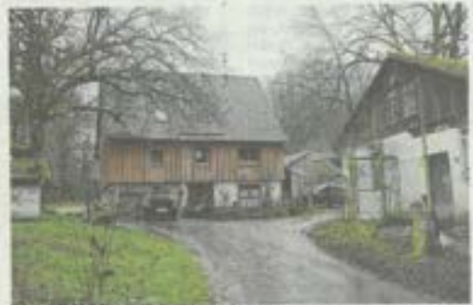
Das Wohnhaus Hinterschöpperg 1. Rechts davon, durch den kleinen Stall im Vordergrund verdeckt, möchten Helmut Lederer und Jutta Ambrosius den großen früheren Stall umbauen. Foto: gth
