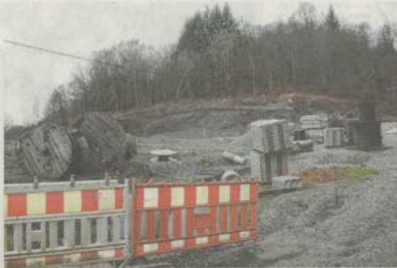
So sieht das Areal derzeit aus: Steingaletten und Kabeltrommeln liegen bereit. Fotos: Gottfried Mahling
