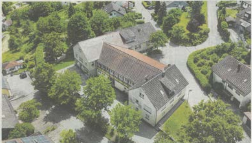
Das Gnadentaler Bürgerhaus besteht eigentlich aus drei zusammenhängenden Gebäuden. Im hinteren ist der Kindergarten untergebracht, im mittleren unter anderem Turnhalle mit Bühne. Der wohl größte Sanierungsbedarf besteht offenbar im Wohnhaus vorn. Foto: Ufuk Ansan
