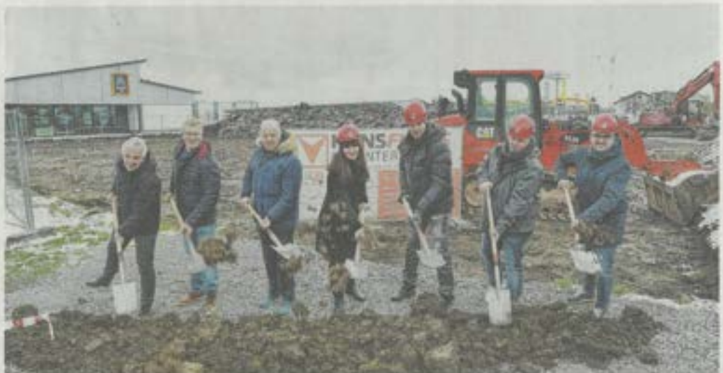
Mit dem Spatenstich im Gewerbegebiet Kerz gaben sie am vergangenen Freitag den Startschuss für den Neubau eines Firmengebäudes für das Haller Unternehmen Eurolink (von links): Klaus Lindenmeyer (Liegenschaftsamt der Stadt Schwäbisch Hall), Martin Bauer (Stellvertreter von Michelfelds Bürgermeister Wolfgang Binsig), Hartmut Baumann (Erster Stellvertreter von Halls Oberbürgermeister Daniel Bullinger), Eurolink-Geschäftsführerin Evgenia Nikova und ihr Sohn Michael Chatov, Architekt Lorenz Kraft und Johannes Veit, Geschäftsführer des Ellwanger Bauunternehmens Hans Fuchs. Foto: Ulfur Anisier
