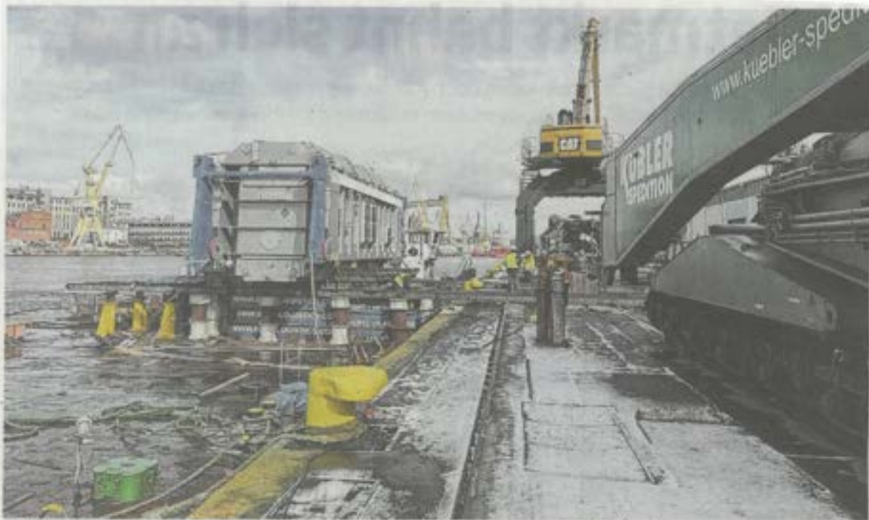
Ein 355 Tonnen schwerer Transformator musste innerhalb weniger Wochen von Bayern nach Mecklenburg-Vorpommern gebracht werden. Dazu wurde der Koloss unter anderem am Hafen von Stettin in den Tragschnabelwagen von Kübler verladen.
