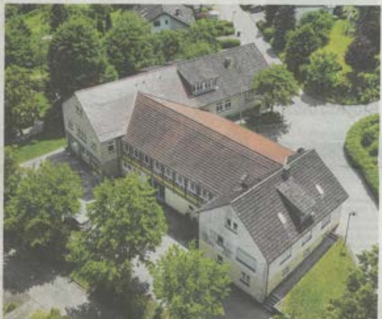
Der Gnadentaler Kindergarten befindet sich im oberen Gebäude des Bürgerhaus-Komplexes. Die Betreuungszeit geht von 7 bis 16 Uhr, was voll berufstätigen Eltern entgegenkommt. Foto: Archiv/Ulfik Arslan
