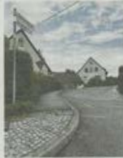
Der Asphalt sowie die Kanäle unter der Schörowaldstraße sind dringend sanierungsbedürftig.
