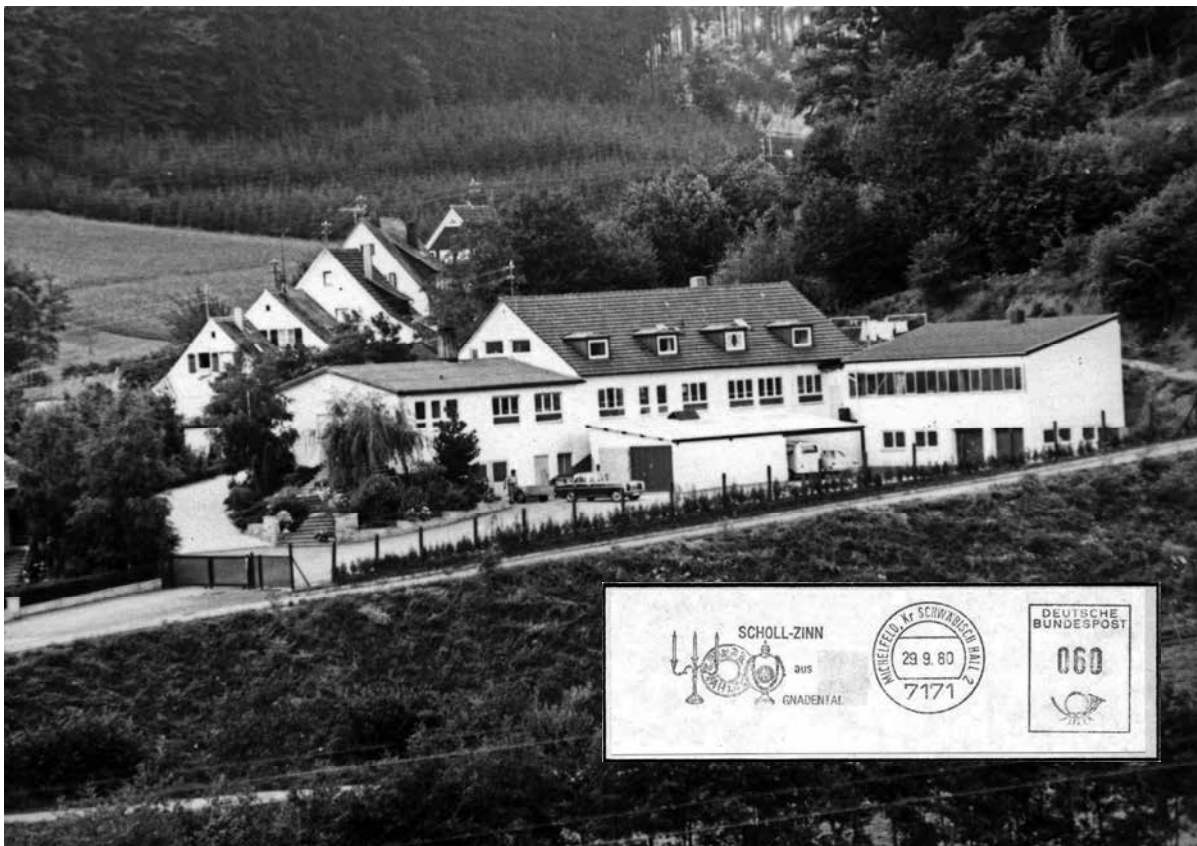
Das stattliche Betriebsgelände in Gnadental in einer Aufnahme aus dem Jahr 1973, Frankierstempel aus dem Jahr 1980
