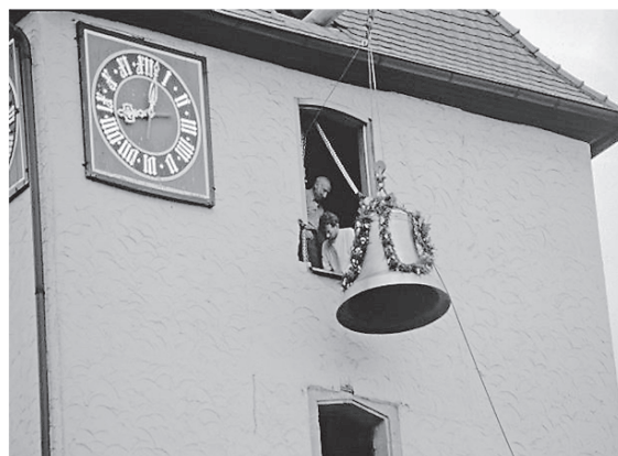
Aufzug und Einbringen der festlich geschmückten Glocke durch das erweiterte Turmfenster
