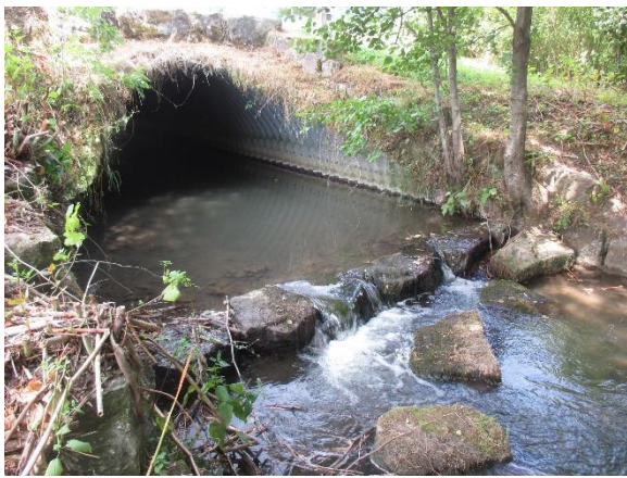
Abbildung 55: Durchlass und Sohlschwelle an der Bibers
