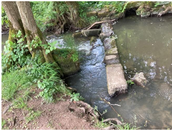
Abbildung 156: Bibers mit historischem Ausleitungsbauwerk am Gnadentaler Mühlkanal
