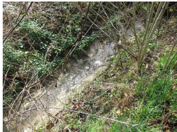
Abbildung 65: Sohlschalen am Streifleswaldbach
