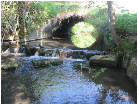
Abbildung 142: Durchlass und Sohlschwelle an der Bibers
