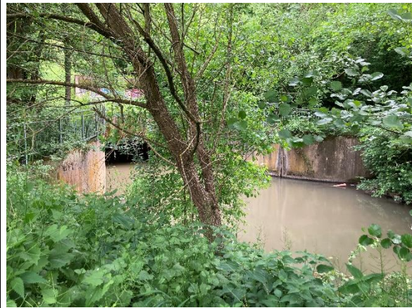
Abbildung 157: Auslassbauwerk der Bibers am Sailach-Stausee
