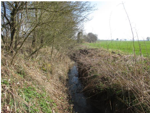
Abbildung 64: Begradigter und im Regelprofil ausgebauter Abschnitt des Niesbachs
