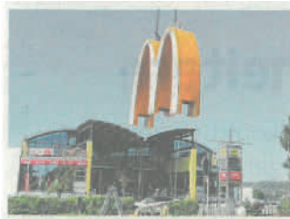
Ein neuer Werbepylon wurde bereits montiert. Foto: Gottfried Mahling
