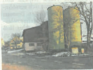
Am ehemaligen Milchviehbetrieb in der Ortsdurchfahrt wird die provisorische Haltestelle eingerichtet. Foto: Archiv
