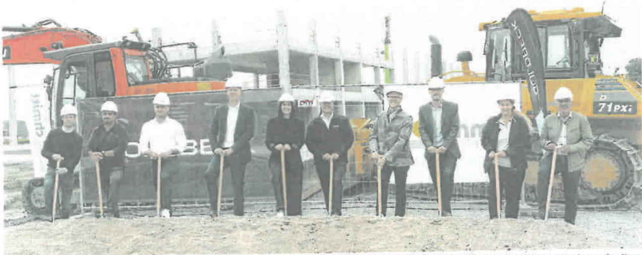
Vertreter der Schmitt-Gruppe, von Goldbeck und der Stadt Schwäbisch Hall feierten den Beginn des Neubaus. Seit einigen Wochen schreiten die Bauarbeiten im Gewerbepark West bereits zügig voran. Foto: Adina Bauer
