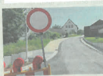
Im unteren Bereich der Schönwaldstraße sind die Arbeiten fast abgeschlossen. Foto: gm
