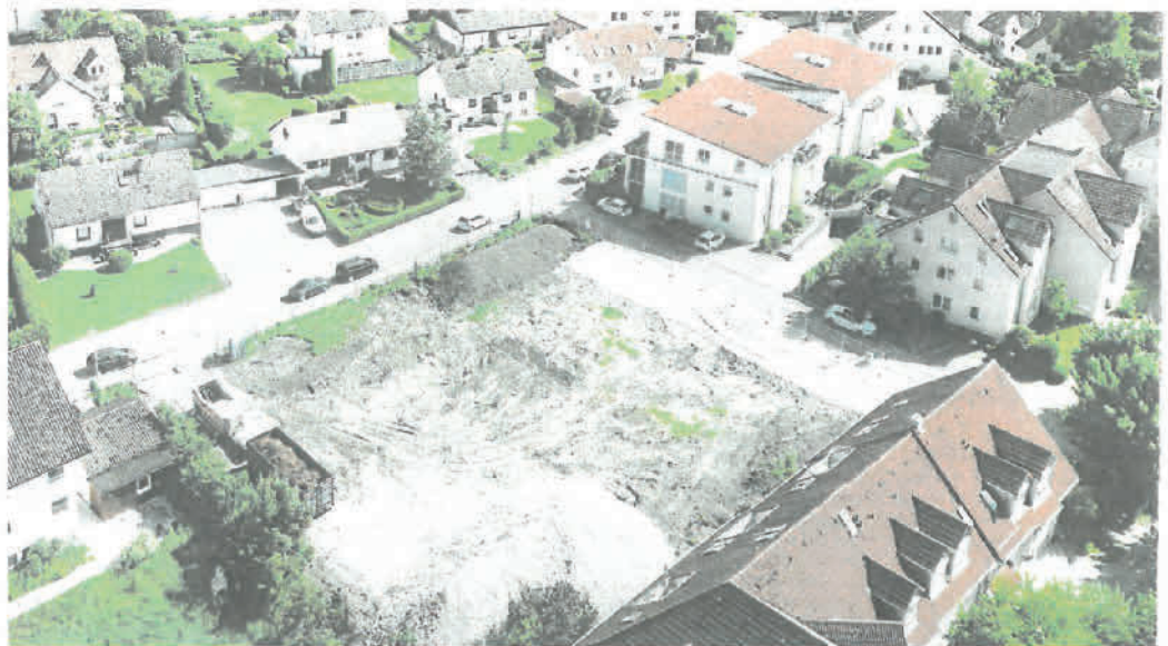
Auf dieser Brachfläche in der Michelfelder Wiesenstraße 9 entstehen drei neue Mehrfamilienhäuser. Vom Vorgängergebäude sind nur noch große Schutthaufen übrig. Foto: Ufuk Arslan
