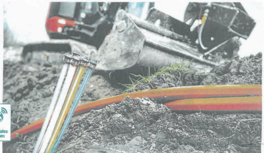
Glasfaserkabel liegen auf einer Baustelle. Im Landkreis Schwäbisch Hall bringt der Zweckverband Breitband den Ausbau der digitalen Infrastruktur voran. Foto: Sina Schuldt/dpa
