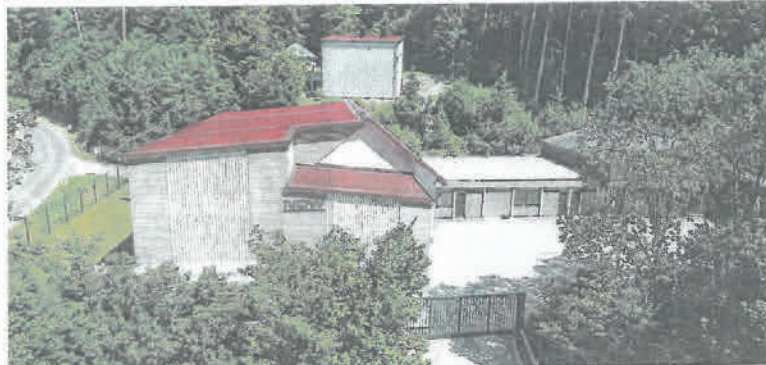
Wasserwerk Schweighausen bei Jagstzell: Hier wird eine Ultrafiltrationsanlage installiert, die die Leistungsfähigkeit des Wasserwerks von 55 auf 80 Liter pro Sekunde erhöht, ein Plus von rund 45 Prozent.
