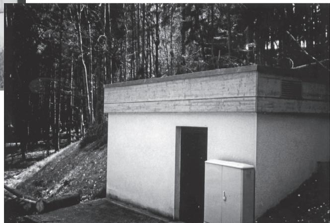
*Im Pumpwerk Riegenhof läuft das Wasser aus sieben Quellen zusammen und wird von dort in den Wasserturm Bubenorbis gepumpt.*
